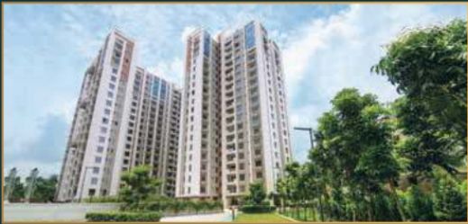
OZONE On South EM Bypass
